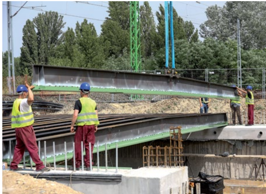
A 2x8 darab acél tartóbetétet daru emelte be a gondosan előkészített helyre. Centiméterre pontosan illeszkednek az elemek.
