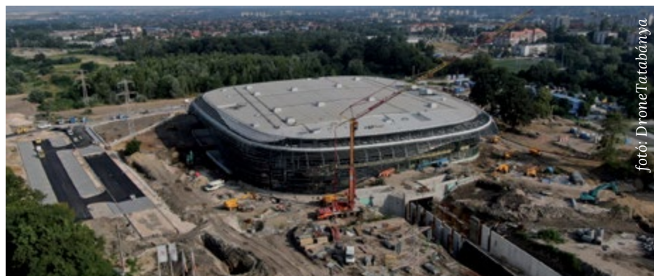
Épül a multifunkciós csarnok Óvárosban.
